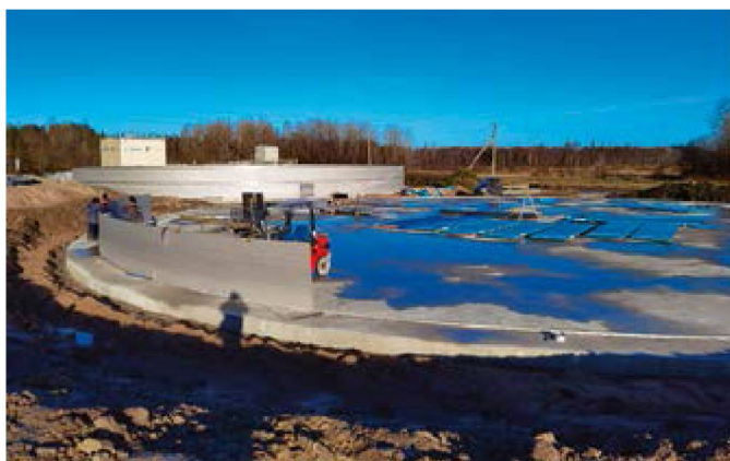
РИС. 10. Монтаж емкостей накопления жидкой фракции
