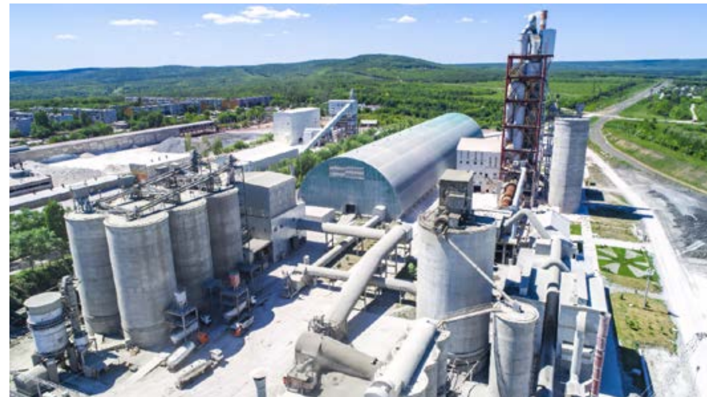
Рисунок 4 — Современный цементный завод сухого способа производства
